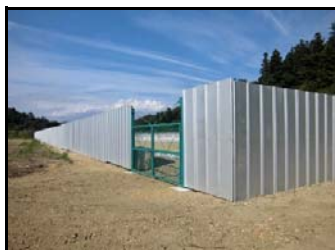
仮置場での遮へい作業
