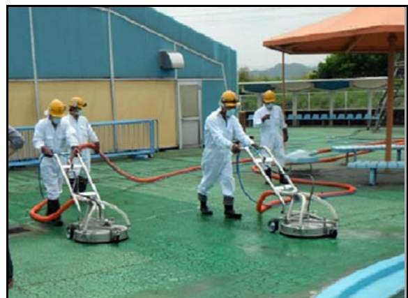
同時吸引型高圧洗浄実施
