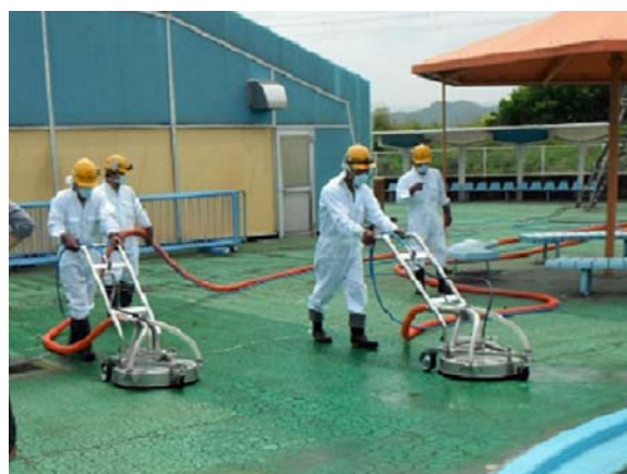
同時吸引型高圧洗浄実施
