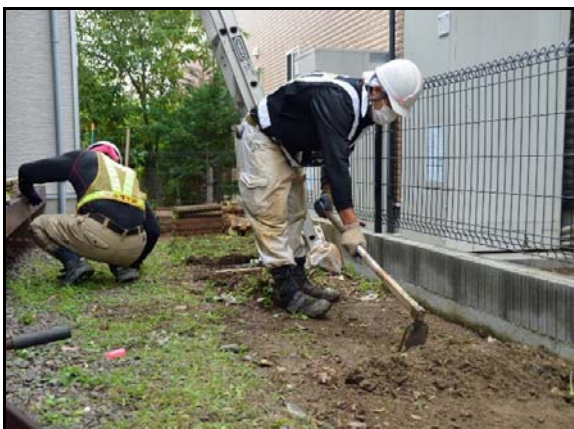
住宅除染での表土はぎ作業
