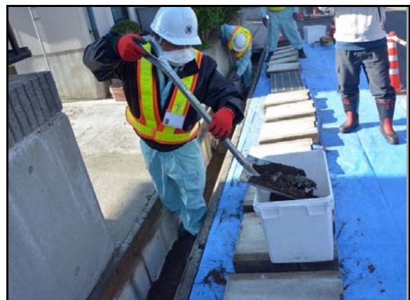
道路除染での側溝土砂あげ作業
