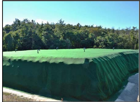
完成された仮置場
