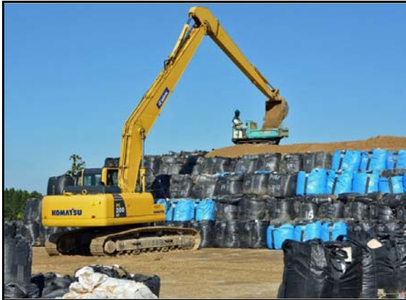
仮置場での遮へい作業
