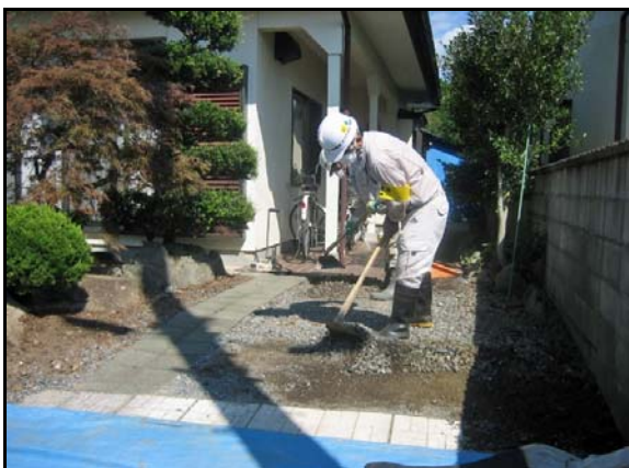
砂利・碎石の除去
