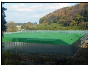
太田川仮置場
