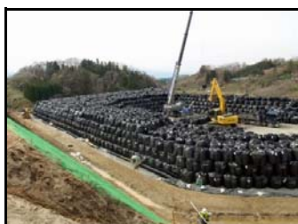
仮置場 搬入中
