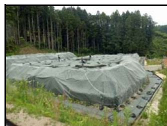
仮置場 搬入済み
