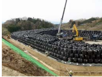
仮置場 搬入中
