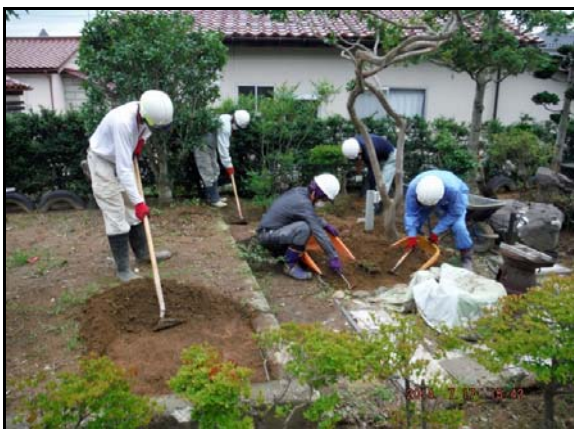
除染作業(表土除去作業)
