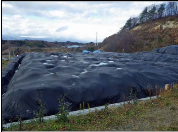
廃棄物を遮水シートで覆って保管
