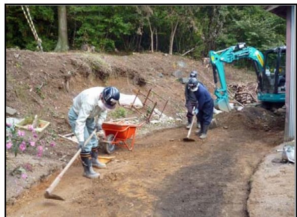
住宅周りの表土除去
