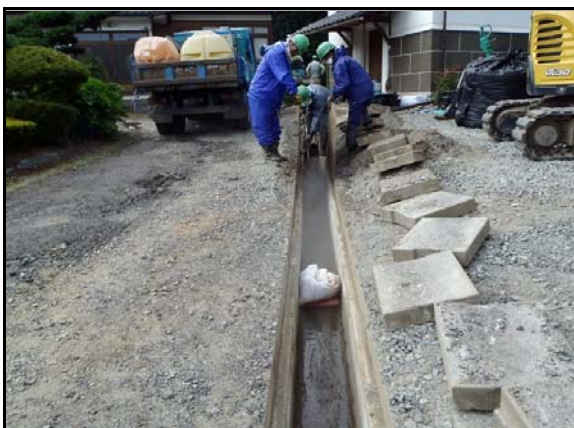
側溝の高圧洗浄
