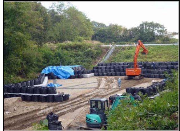
周辺を遮へい土のうで覆い、廃棄物を据付
