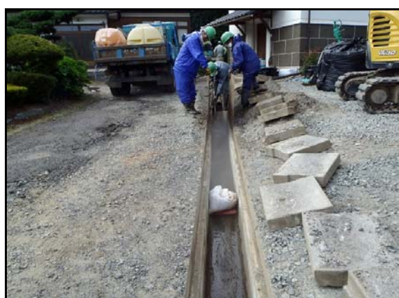
側溝の高圧洗浄
