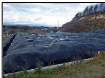
除去土壌等を遮水シートで覆って保管
