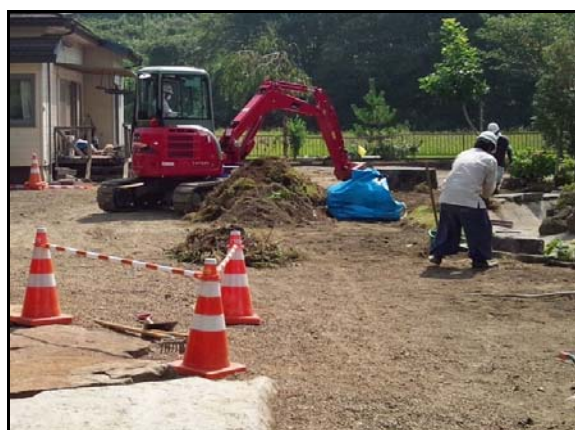
住宅敷地内の除染作業
