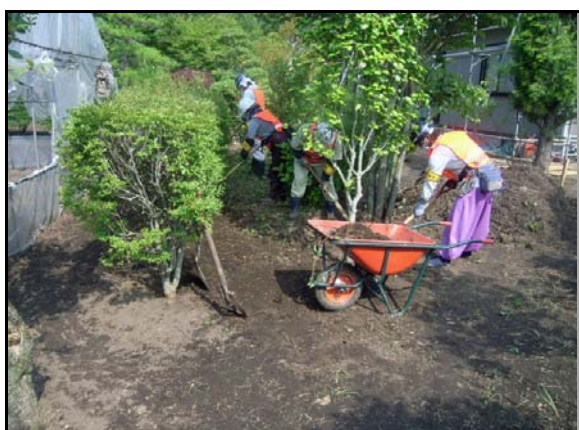
汚染土壌剥ぎ取り作業
