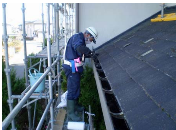
雨樋の除染作業
