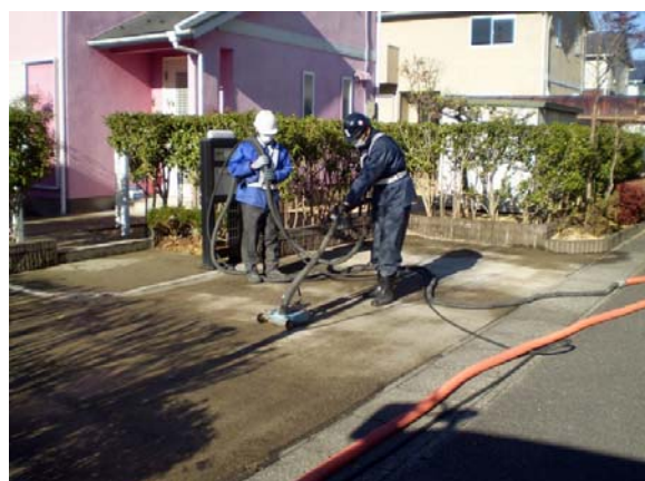
コンクリート洗浄作業
