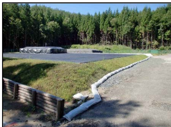
手前: 2号(不燃物)置場、奥: 3号(可燃)置場
