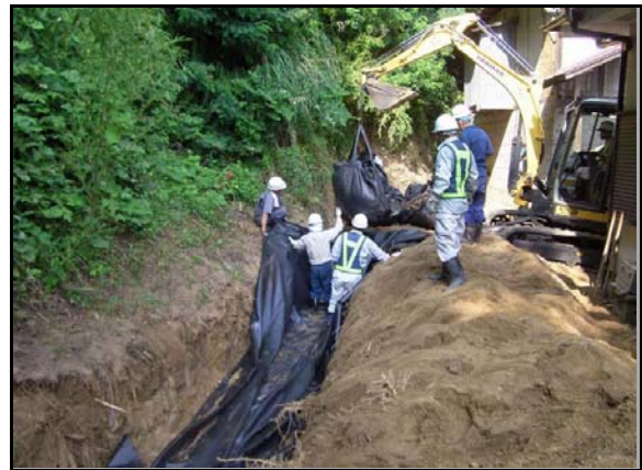
フレコン埋設作業
