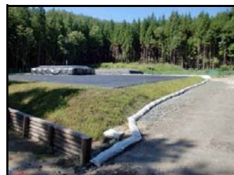
手前: 2号(不燃物)置場 奥: 3号(可燃)置場
