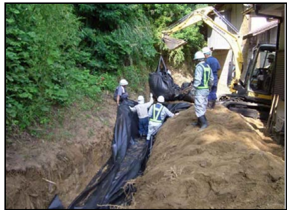
フレコン埋設作業
