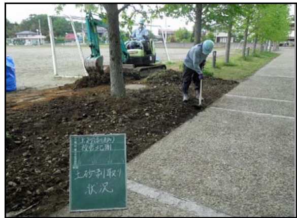
社川小学校除染状況
