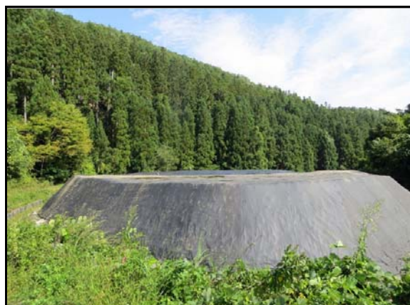
高内仮置場全景
