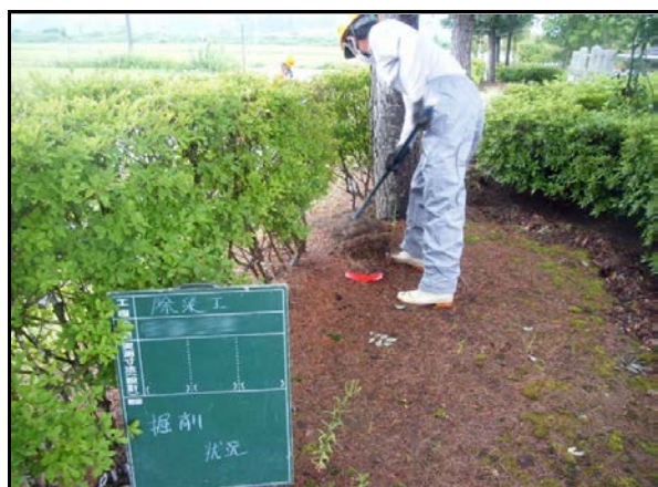
役場周辺除染(表土の剥ぎ取り)
