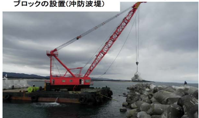
ブロックの設置(沖防波堤)
