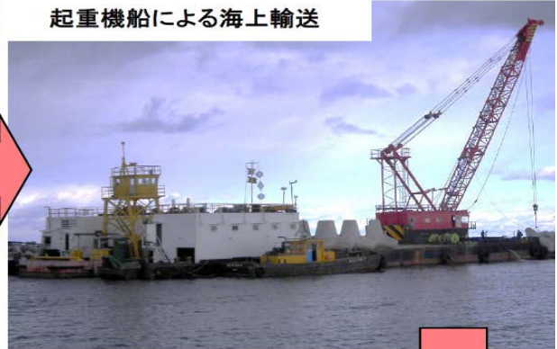
ブロックの設置(沖防波堤)
