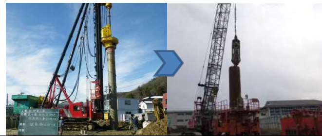
掘削状況写真（左：オーガー掘削、右：CD工法）
