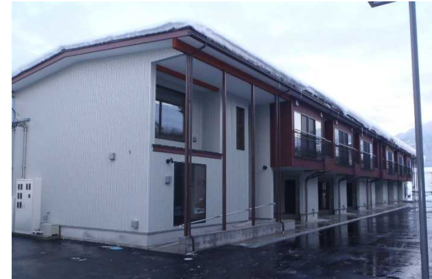
建物外観(南西方向より)
