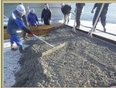
現場打コンクリートの施工状況
