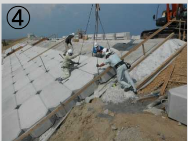
④ 2次製品ブロックの据付状況
