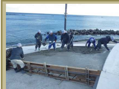
現場打コンクリートの施工状況
