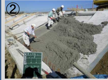
② 均しコンクリートの施工状況
