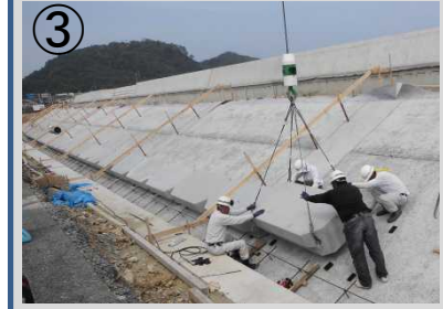
③ 2次製品ブロックの据付状況
