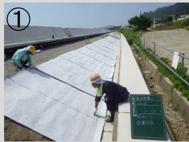
① 遮水シートの施工状況
