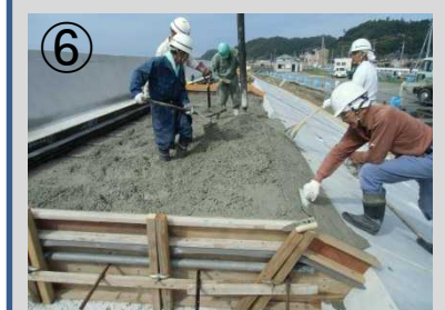
⑥ 天端コンクリートの施工状況
