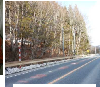
簡易積雪深標尺 (原町川俣線 八木沢峠)
