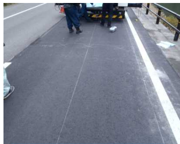
切削箇所に印を付ける
