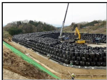
仮置場 搬入中
