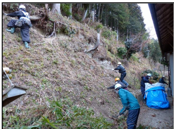
夏井地区除染作業
