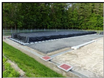
夏井地区仮置場(可燃物)
