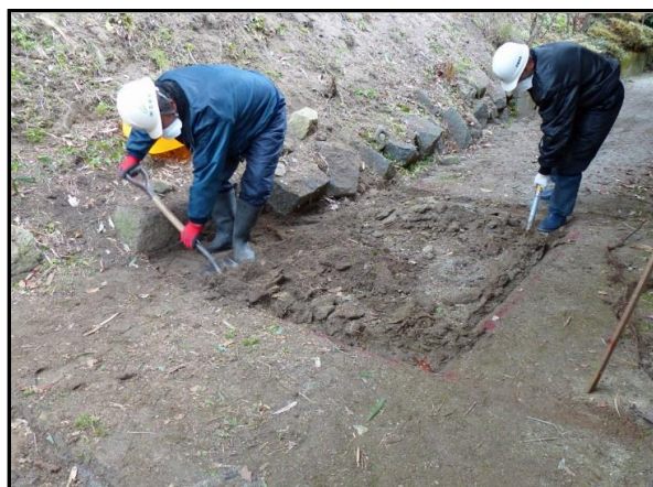
夏井地区除染作業
