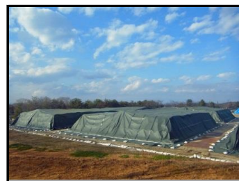
陸上競技場仮置場
