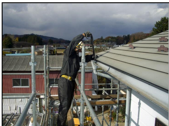
縦樋除染作業状況
