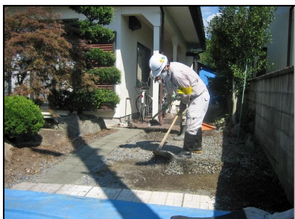
砂利・碎石の除去
