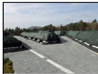
川前10区第3仮置場
