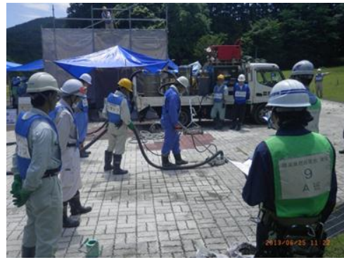
【写真】 H25.6.25 吸引型高圧洗浄
