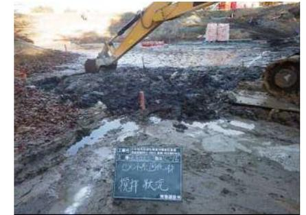
施工中(セメント系固化材の混合状況)
