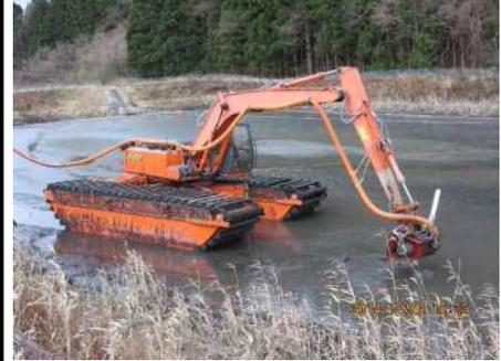
①泥上掘削機による掘削
