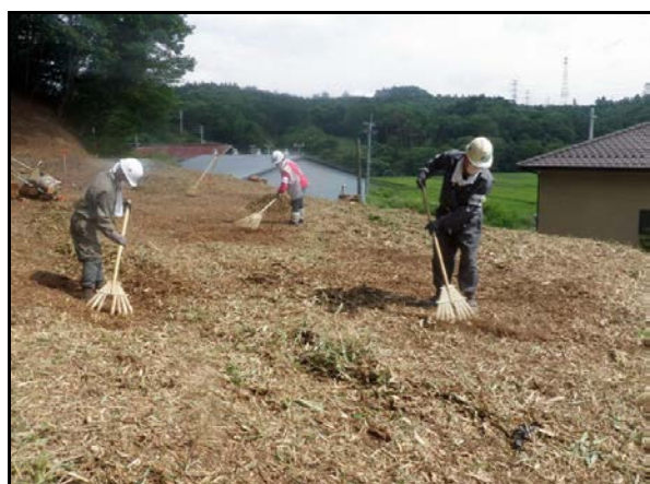
森林(生活圏)の除染状況(堆積物除去)
