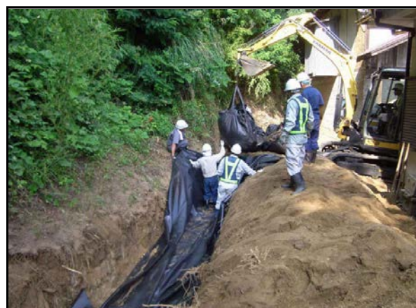
フレコン埋設作業
