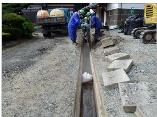
側溝の高圧洗浄
