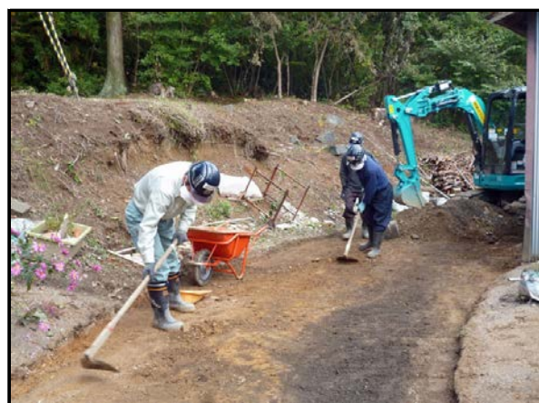
住宅周りの表土除去
