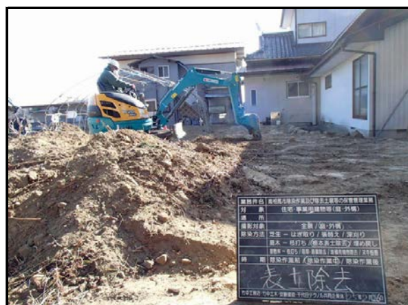
庭除染作業中
