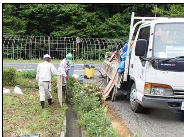
側溝除染作業中
