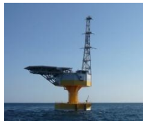
洋上変電所 「ふくしま絆」
