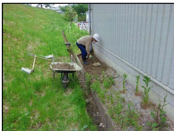
除染(表土剥ぎ取り)
