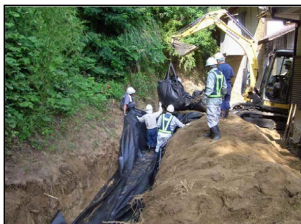
フレコン埋設作業
