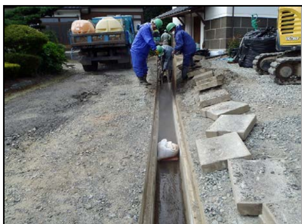
側溝の高圧洗浄
