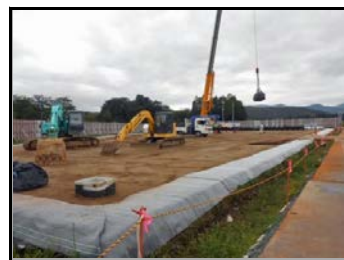
仮置場造成・搬入状況
