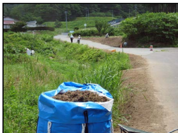
道路除染状況
