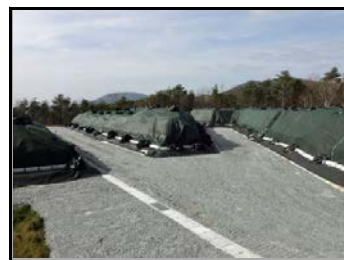
川前10区第3仮置場
