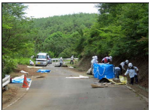
道路除染状況
