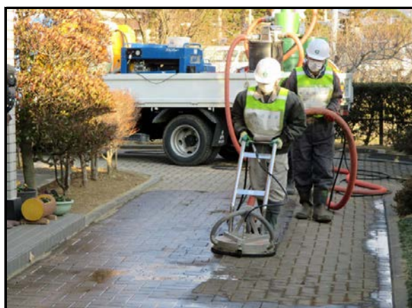
回収型高圧洗浄機による作業
