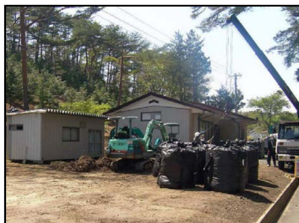
公共施設の除染状況(フレコン運搬)
