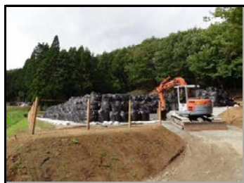
通気性防水シートキャッピング前
