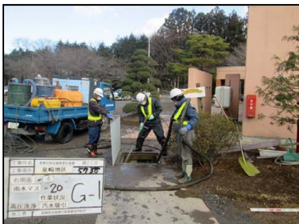
枞除染作業状況
