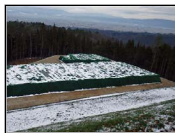
完成された仮置場
