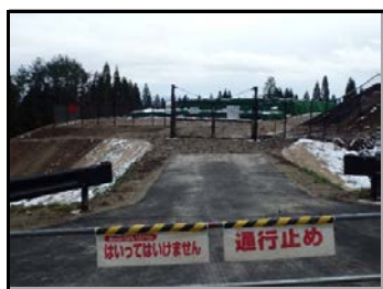
仮置場での遮へい作業
