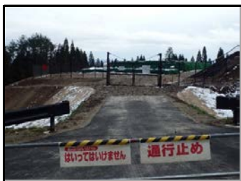
仮置場での遮へい作業
