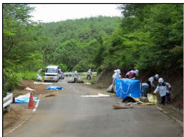
道路除染状況
