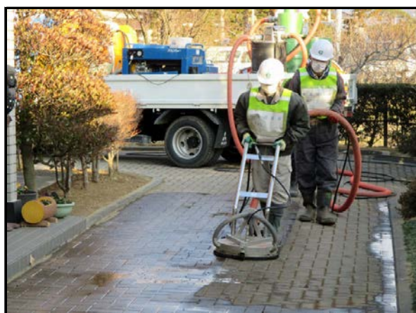
回収型高圧洗浄機による作業
