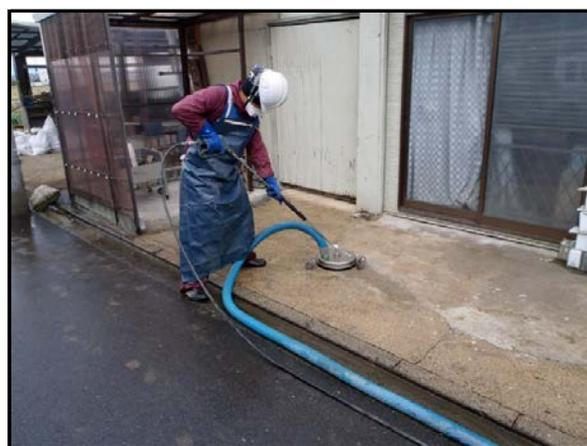
吸引型高圧洗浄によるコンクリートたたき等の除染作業
