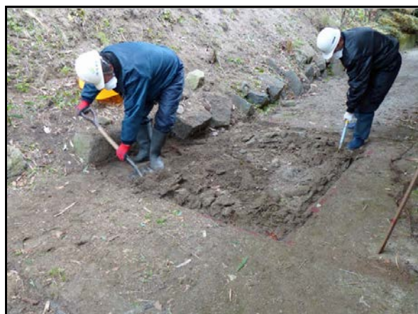
夏井地区除染作業
