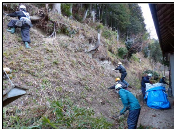
夏井地区除染作業
